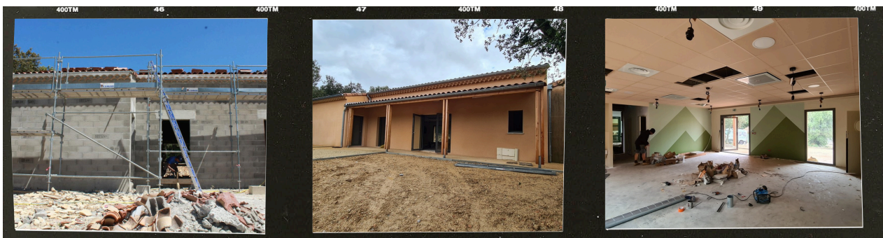
La réception des travaux a eu lieu le 11 décembre
